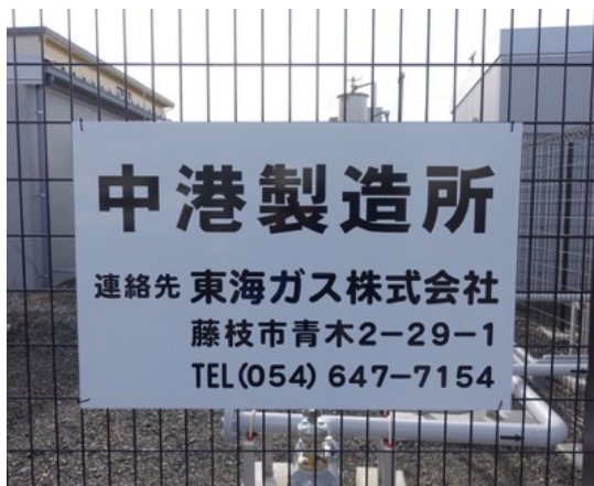
温泉メタン都市ガス化施設
