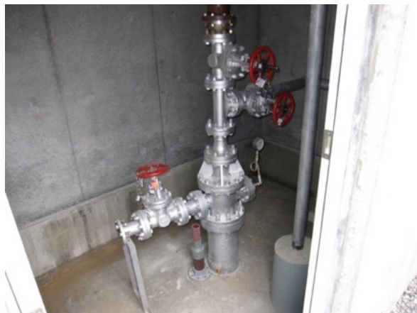
温泉用掘削井(深度1,148 m)
