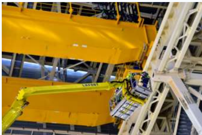
容量750トンのクレーン2組の設置風景
