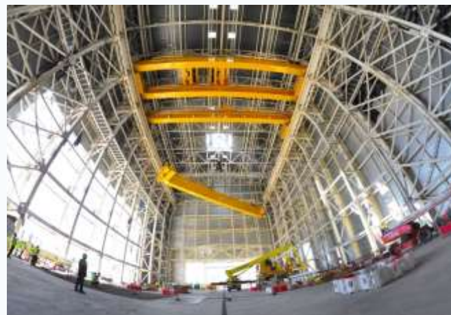
容量750トンのクレーン2組の設置風景
