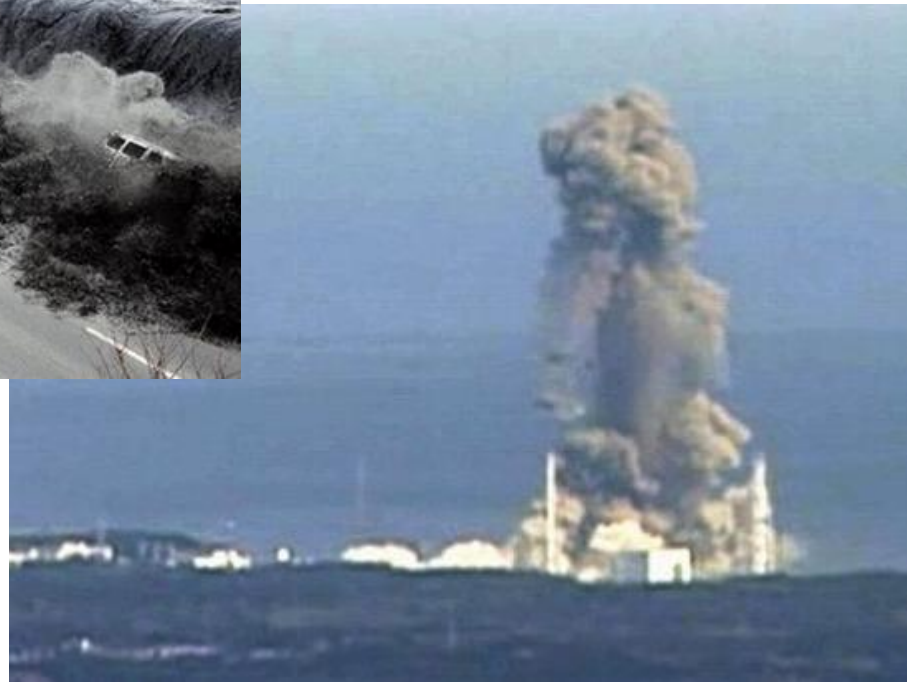
東京電力福島第一原子力発電所
